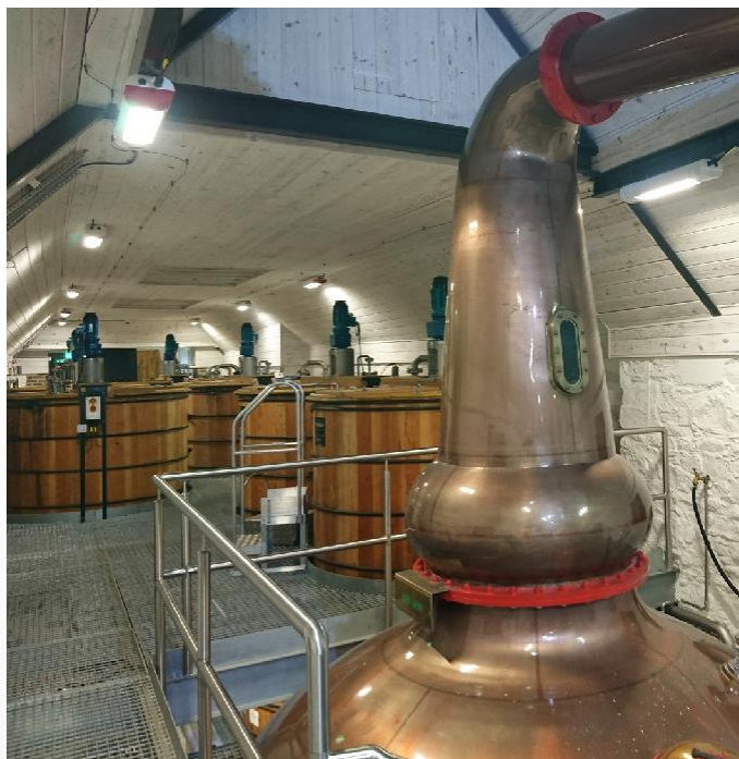
Torabhaig è una fattoria e fattoria tradizionale, ora convertita in una moderna distilleria. Sono stati installati un misto di apparecchi SPARTAN Zona 1 e Zona 2, tutti dipinti di bianco per integrarsi con la pannellatura in legno già presente.
